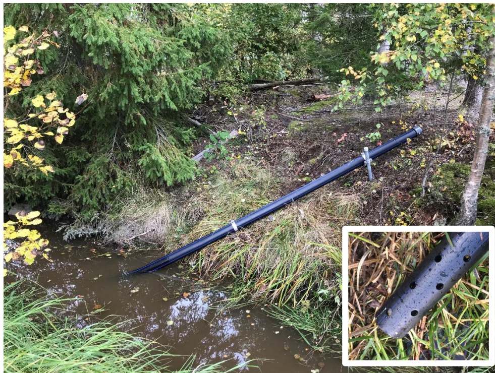
Figur 10. Installation av sond i rör som lutar snett med vattenflödets riktning. Julmyrabäcken. Den perforerade nedre delen av röret som är placerad i vattendraget.
