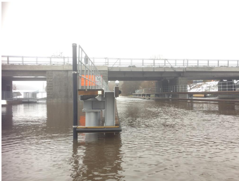
Figur 11. Installation av sond i lodrätt rör vid ett brofäste i Fyrisån, Flottsund.
