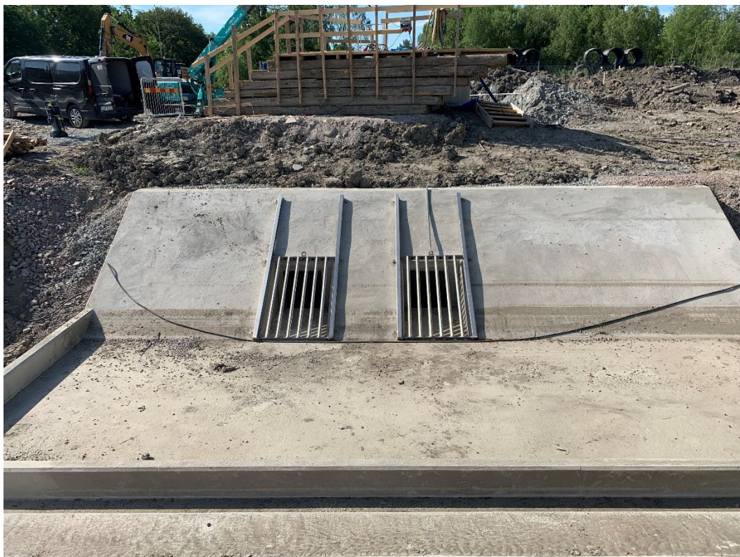
Figur 5. Intagsrännan i förgrunden och i bakgrunden pågår arbete med pumpstationen. Foto: Gustav Myhrman.
