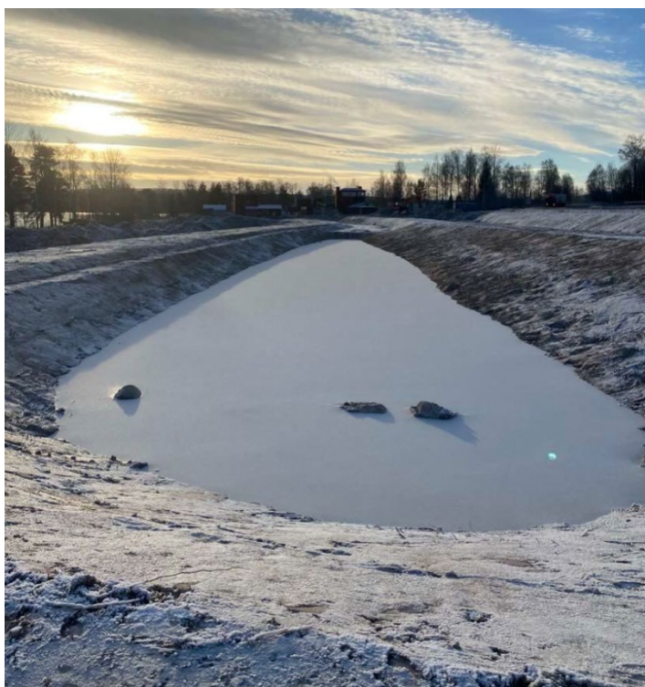
Figur 16 Damm med renignsverket i bakgrunden
