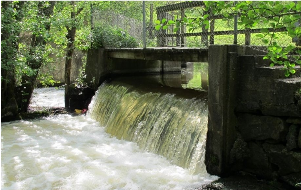
Figur 4. Nygårdsdammen före åtgärd 2022. Foto: Trosa kommun.
