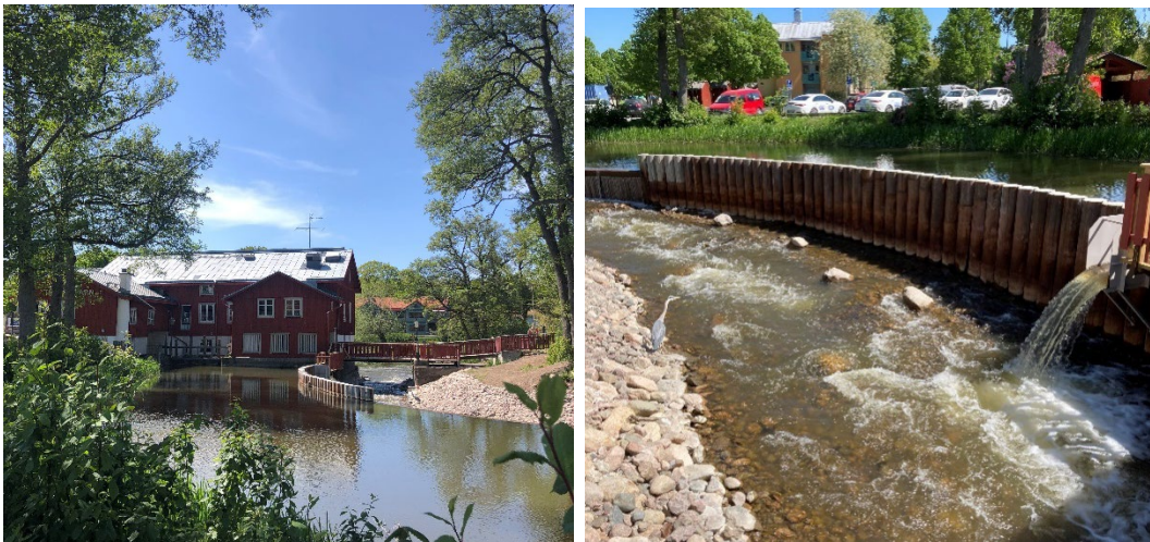
Figur 2 och 3. Trosa kvarn efter åtgärd i maj 2023. Till vänster ses kvarnen sett framifrån med det nybyggda inlöpets mynning till höger om vattenspegeln. Den högra bilden visar inlöpets mynning från andra hållet.
