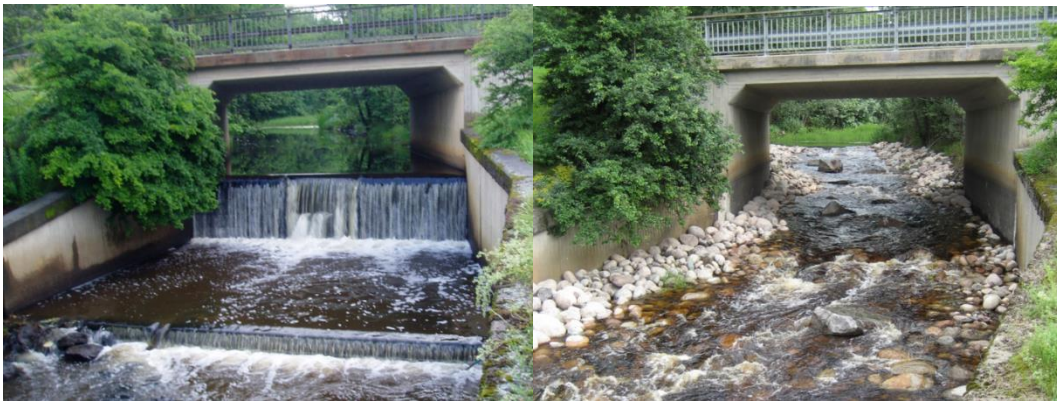
Figur 19. Damm i Imälven Karlskoga före och efter utrivning. Foto: Daniel Bergdahl.
