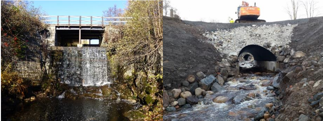
Figur 18. Branddammen vid Guldsmedshyttan före och efter utrivning. Foto: Daniel Bergdahl.
