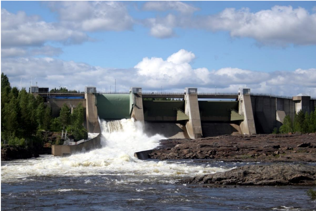
Figur 5. Stornorrfors i Umeälven är ett bra exempel på en lamelldamm. Foto Tage Olsin. Licens CC-BY-SA .
