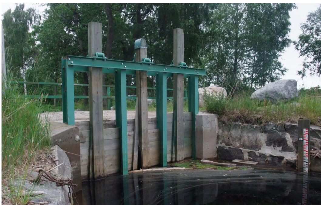
Figur 10. Spettluckedamm vid Västra Laxsjön, Örebro län. Foto: Länsstyrelsen Örebro län.
