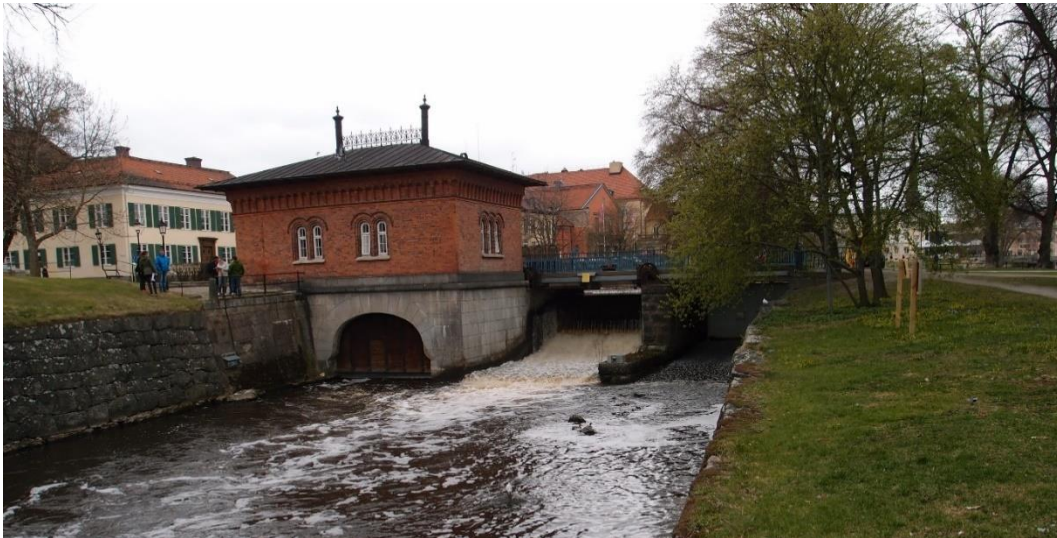
Figur 9. Klafflucka vid Turbinbron i Västerås. Foto: Jonas Berglind
