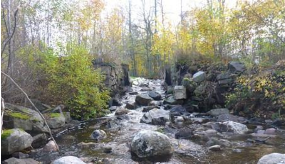
Figur 15. Upptröskling vid Lassåna kvarndamm i Laxån där del av dammstrukturen finns kvar. Foto Länsstyrelsen Örebro län.
