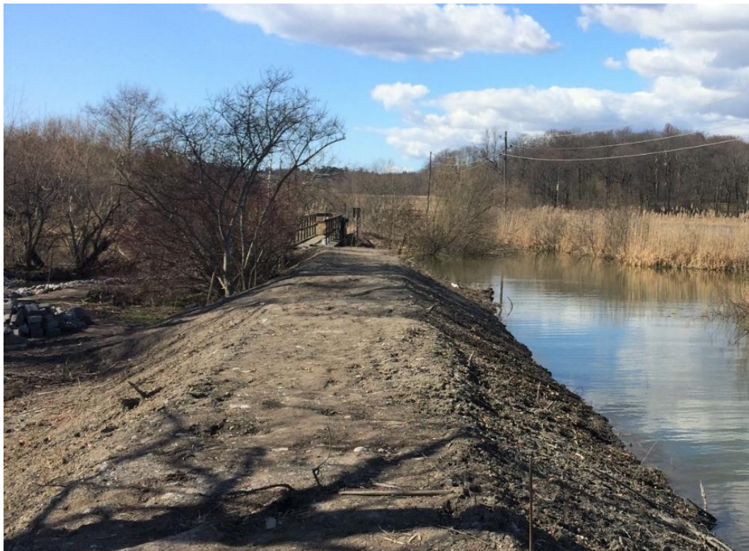
Figur 1. Hjälstavikens damm utgörs av en jordfyllningsdamm med tät kärna av plastspont (syns inte). Foto Länsstyrelsen Uppsala län.
