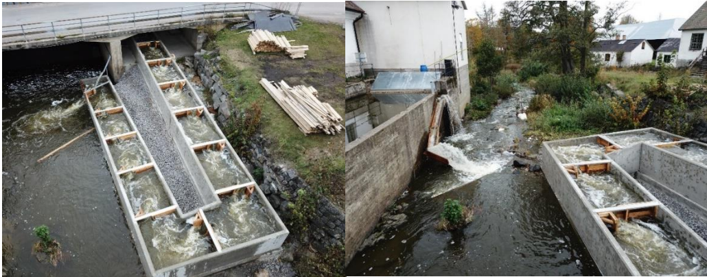
Figur 16. Slitsränna i Strömsbergsbruk anlagd i område med kulturmiljövärden, Tämnarån Uppsala län. Foto Länsstyrelsen Uppsala län.
