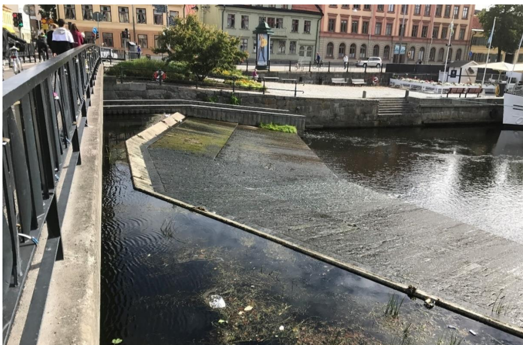
Figur 7. Skibord med fiskpassage i form av slitsränna i borte delen av foto, Islandsfallet Uppsala län. Foto Länsstyrelsen Uppsala län.
