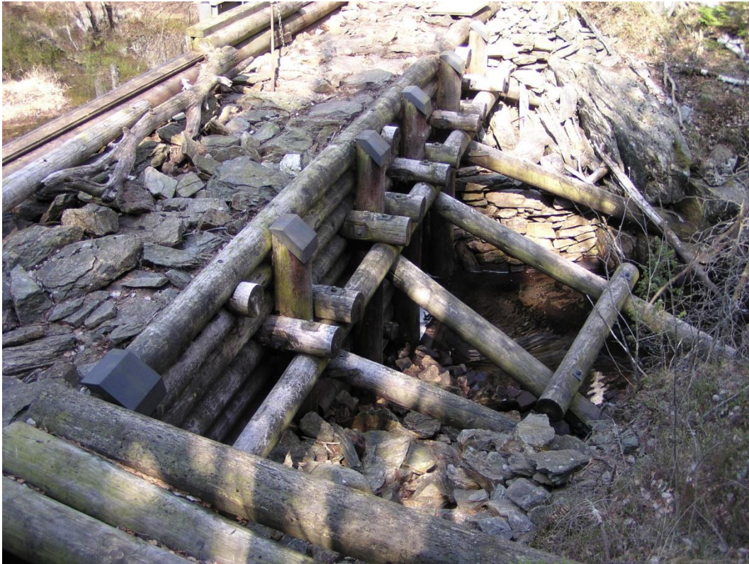
Figur 2. Trädamm med stödjande stenistor (kistdamm). Foto Åke Engström.
