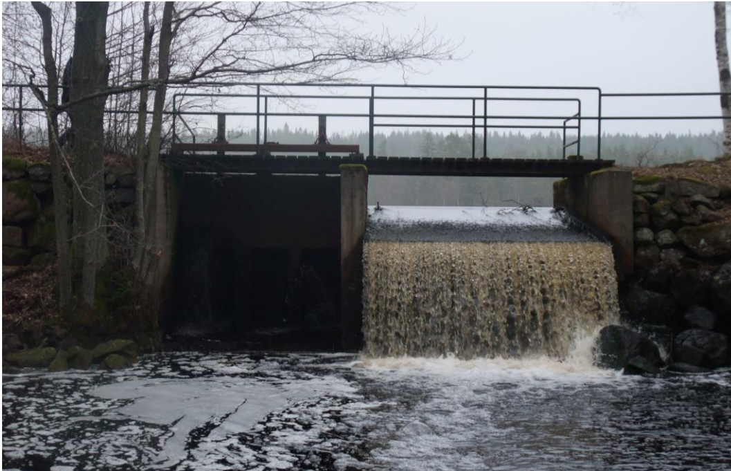
Figur 6 Åbydammen i Finnerödja, Örebro län är exempel på överfallsdamm. Foto: Länsstyrelsen Örebro
