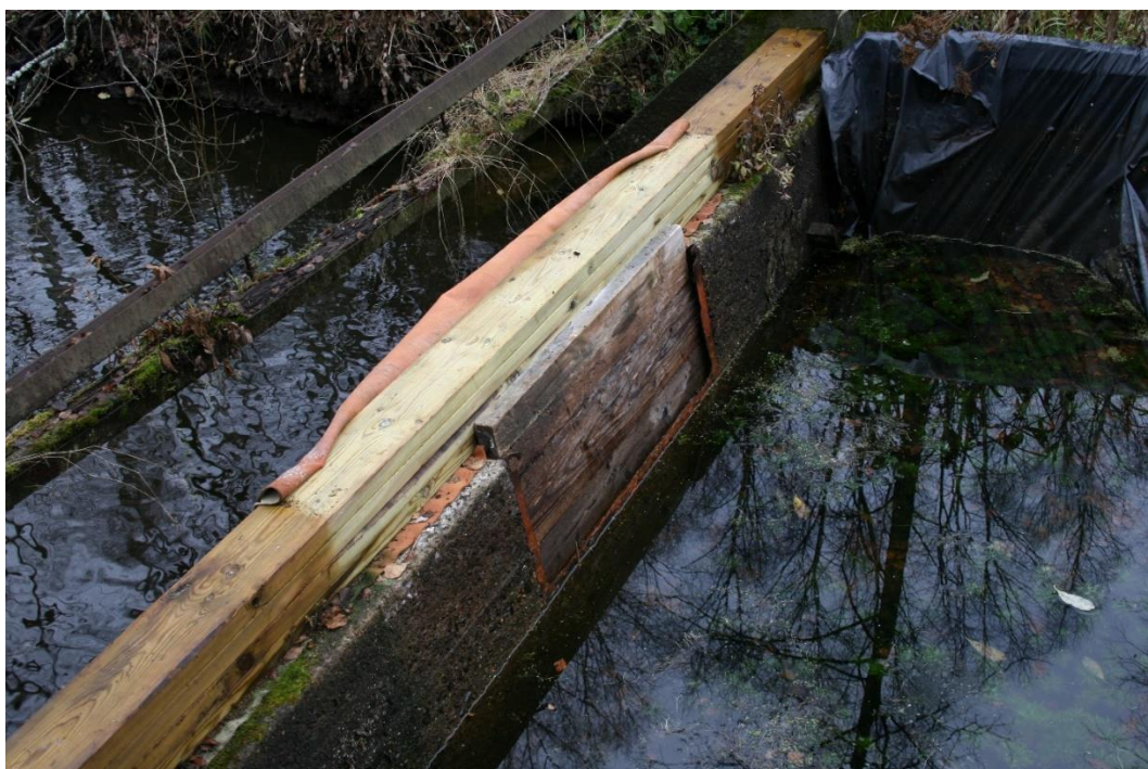
Figur 8. Sättdamm i utloppet av Assjösjön, Uppsala län. Foto Länsstyrelsen Uppsala län.
