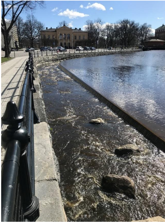
Figur 14. Inlöp vid Turbinbron i Västerås. Foto: Jonas Berglind
