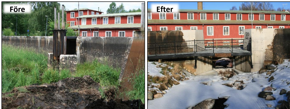
Figur 40. Färgeridammen i Hökesån före och efter utrivningen 2010 (Foto: Jönköpings Fiskeribiologi AB).
