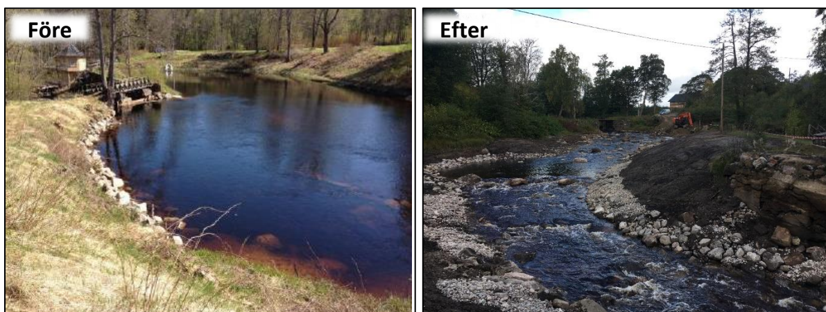
Figur 12. Dammen vid Baggå Herrgård i Hedströmmen före och efter utrivningen 2017 (Foto: LM Miljö & Vattenvård AB).
