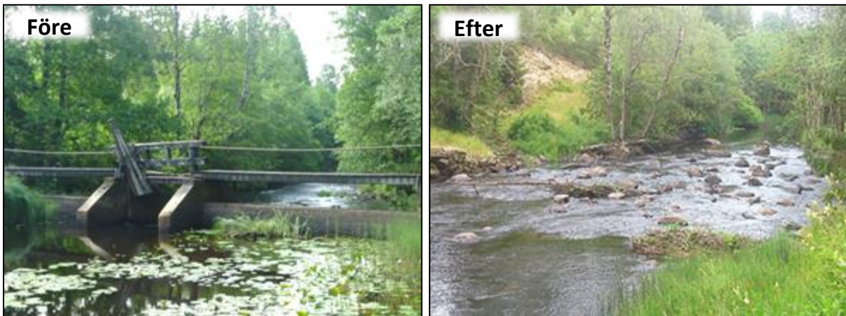
Figur 50. Timmershult i Västerån före och efter utrivningen 2012 (Foto: Jönköpings Fiskeribiologi AB).
