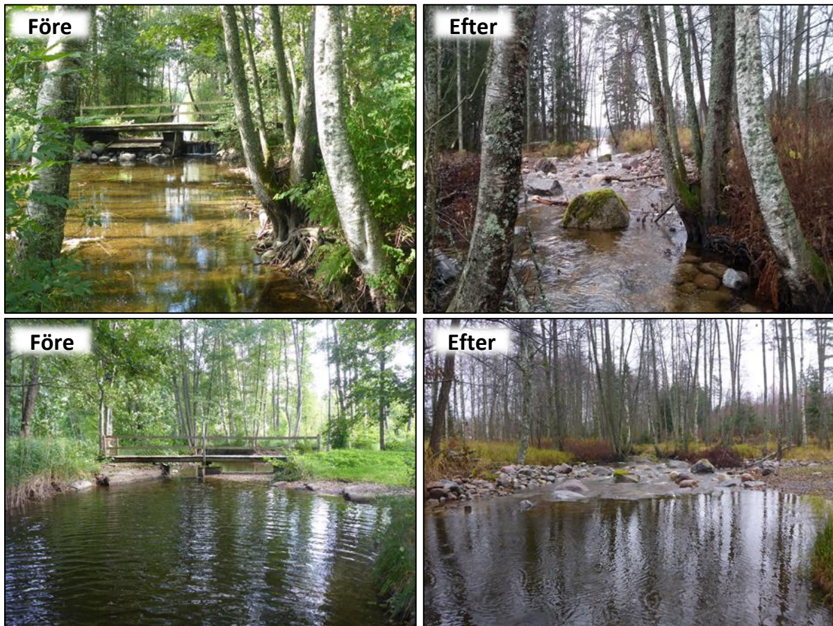
Figur 24. Multens regleringsdamm i Lillån/Mullhytteån före och efter utrivningen 2017 (Foto: Länsstyrelsen i Örebro län).
