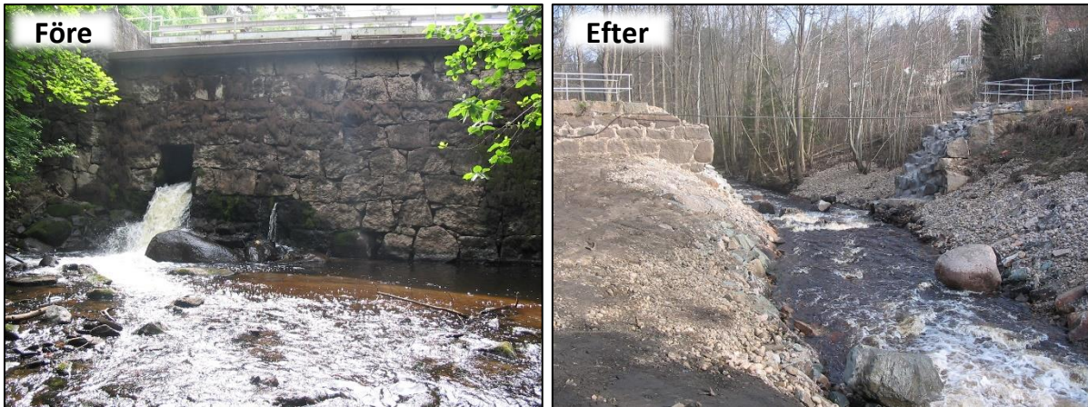
Figur 42. Hökhultsdammen i Tabergsån före och efter utrivningen 2005 (Foto: Jönköpings Fiskeribiologi AB).
