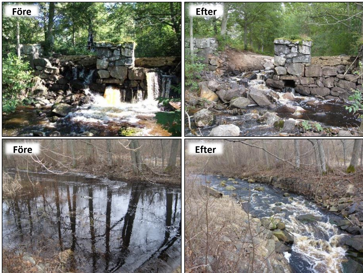
Figur 29. Sägaretorp sprängstensdamm i Sägkvärnsbäcken före och efter utrivningen 2009 (Foto: Länsstyrelsen i Örebro län).
