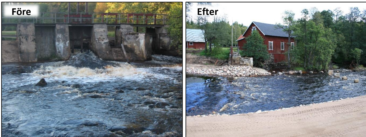
Figur 47. Unneforsdammen i Nissan före och efter utrivningen 2007 (Foto: Jönköpings Fiskeribiologi AB).
