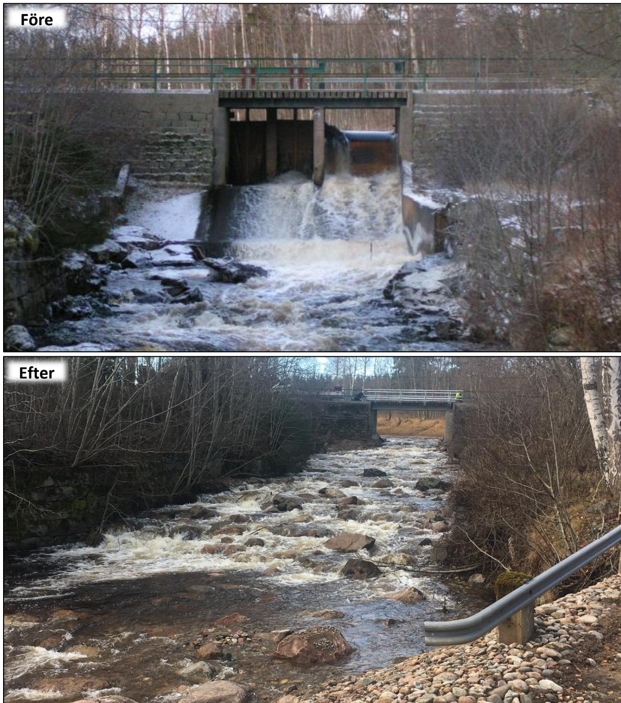
Figur 11. Dammen vid Nedre Borgfors i Hedströmmen före och efter utrivningen 2017 (Foto: LM Miljö & Vattenvård AB).
