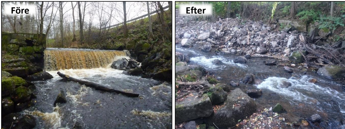
Figur 41. Dammen i Hembygdsparken Hovslätt i Tabergsåån före och efter utrivningen 2018 (Foto: Jönköpings Fiskeribiologi AB).
