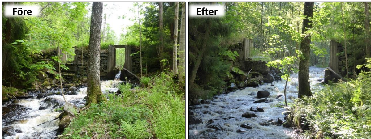
Figur 31. Den nedre dammen i Fräsebäcken före och efter utrivningen 2013 (Foto: Länsstyrelsen i Örebro län).
