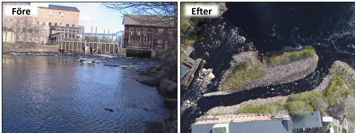
Figur 49. Emsfors i Emån före och efter utrivningen 2011 (Foto: Jönköpings Fiskeribiologi AB).
