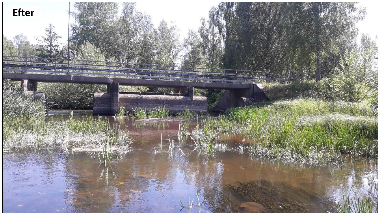
Figur 35. Höger sida av Vriggebodammen i Svartån efter utrivningen 2006. Notera de ursågade skibordsdelarna (Foto: Jönköpings Fiskeribiologi AB).
