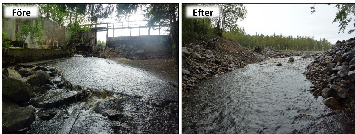
Figur 52. Ekeforsdammen i Fagerhultån före och efter utrivningen 2010 (Foto: Jönköpings Fiskeribiologi AB).
