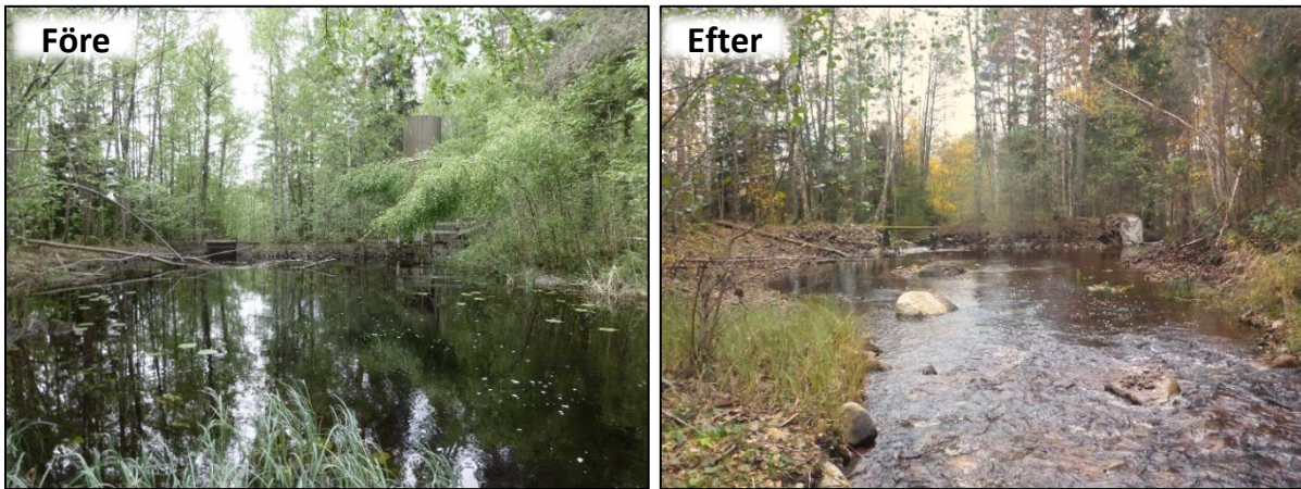
Figur 33. Sågdammen i Fräsebäcken före och efter utrivningen 2013 (Foto: Länsstyrelsen i Örebro län).
