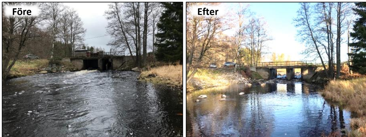
Figur 28. Angsjödammen i Valån före och efter utrivningen 2018 (Foto: Länsstyrelsen i Örebro län).
