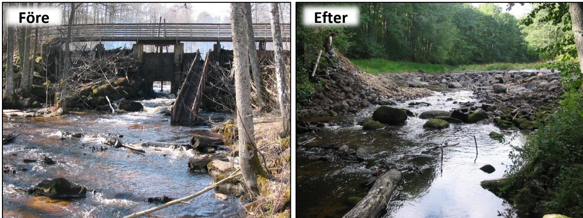
Figur 39 Laggaredammen i Hökesån före och efter utrivningen 2005 (Foto: Jönköpings Fiskeribiologi AB).
