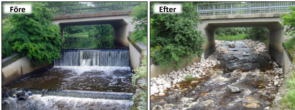
Figur 27. Dammar vid E18 i Imälven före och efter utrivningen 2010 (Foto: Länsstyrelsen i Örebro län).
