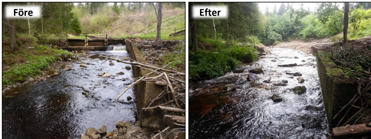
Figur 17. Kronohyttans damm i Hammarskogsån före och efter utrivningen 2015 (Foto: Länsstyrelsen i Örebro län).
