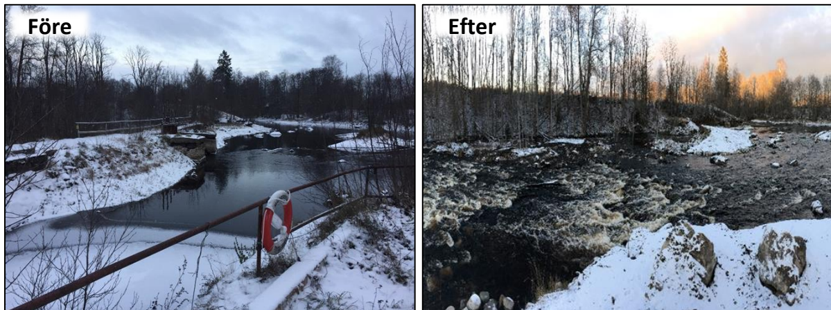
Figur 20. Dammen vid Holmens kraftverk i Hedströmmen före och efter utrivningen 2017 (Foto: LM Miljö & Vattenvård AB).
