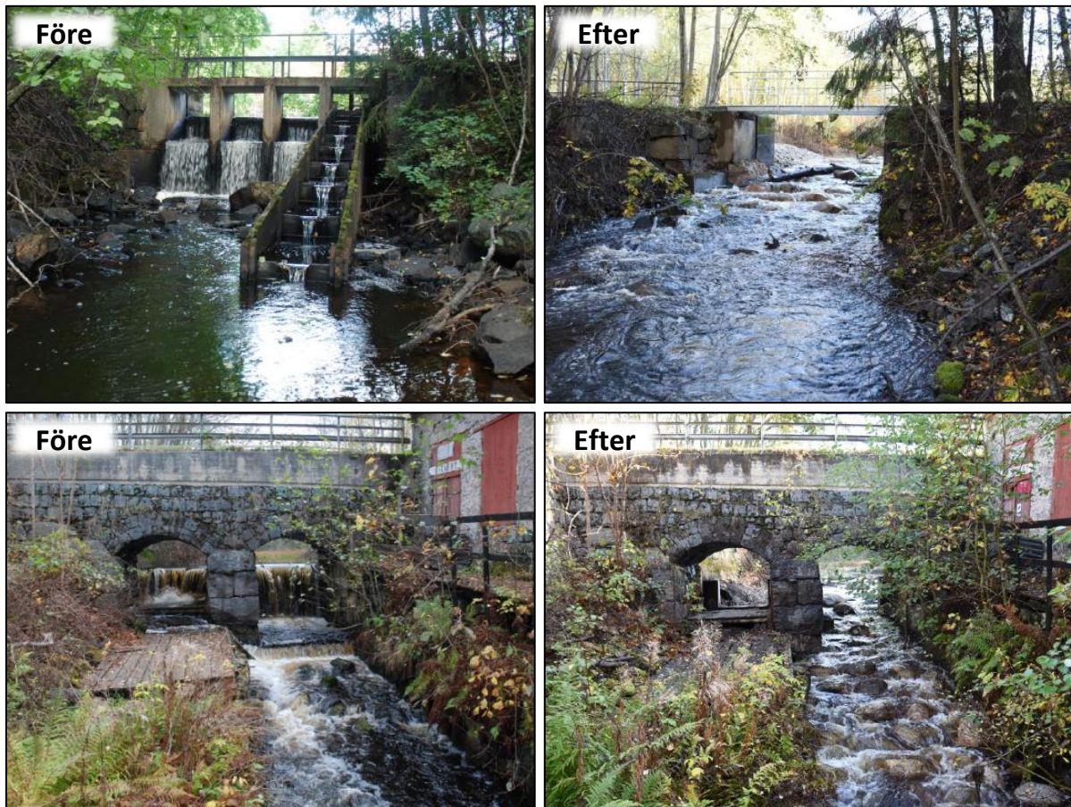
Figur 14. Dammarna vid Hyttdammen i Lankälven före och efter utrivningen 2017 (Foto: Länsstyrelsen i Örebro län).
