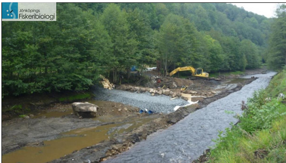
Figur 9. Utrivningen av Massadammen i Tabergsåån. Arbetsområdet avgränsades av en brant väglänt utmed ena sidan och ett järnvägsspår utmed andra sidan. Därför krävdes omfattande planering och logistik för att kunna genomföra åtgärderna samtidigt som stundtals höga flöden skulle ledas förbi.
