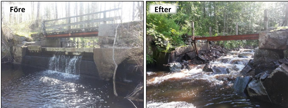
Figur 18. Herrgårdsdammen i Hammarskogsån före och efter utrivningen 2015 (Foto: Länsstyrelsen i Örebro län).
