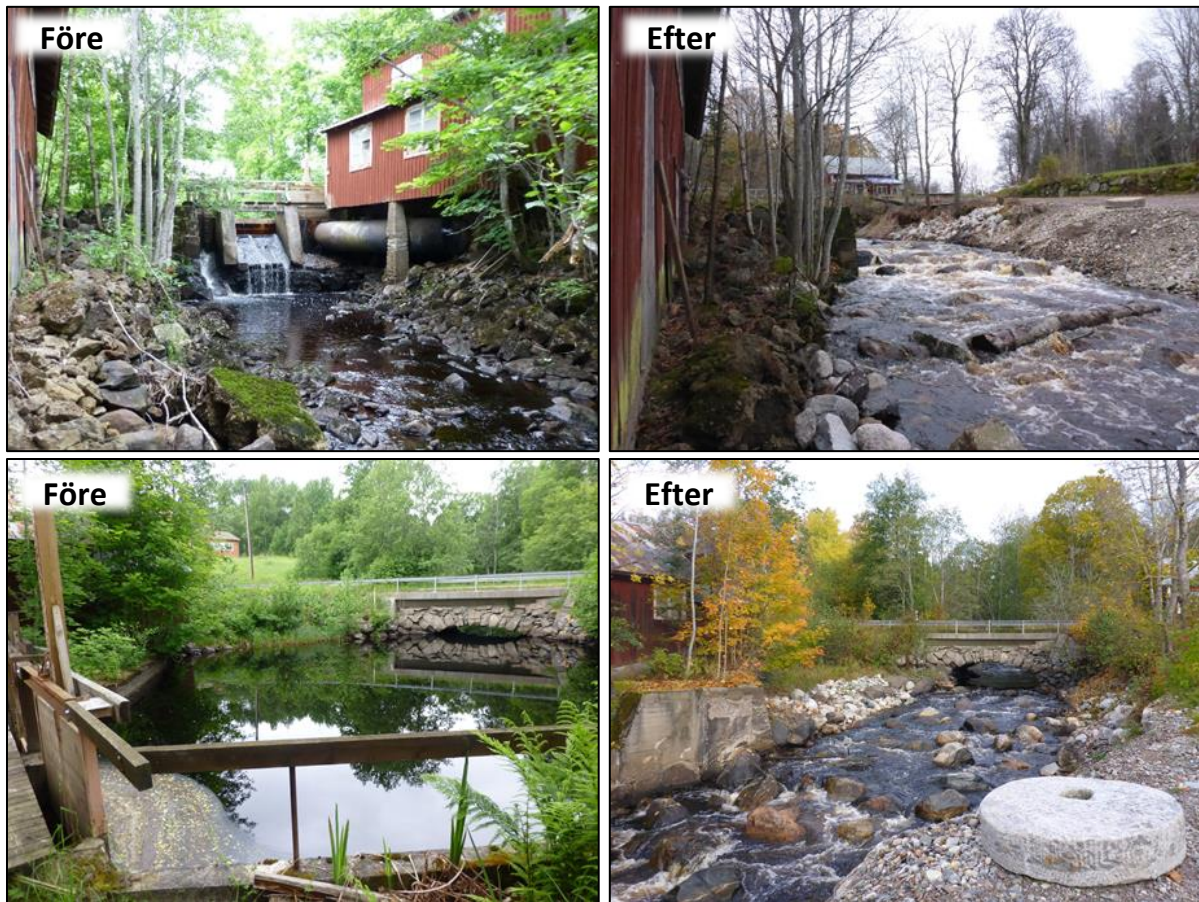
Figur 26. Utterbäckskraftstation i Imälven före och efter utrivningen 2014 (Foto: Länsstyrelsen i Örebro län).
