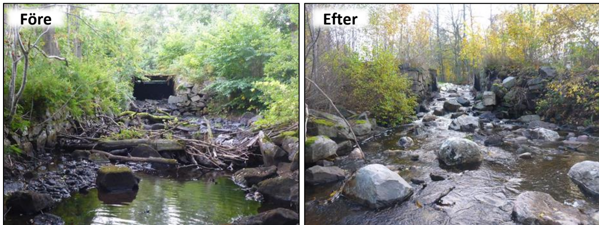
Figur 25. Lassåna kvarndamm i Laxån före och efter utrivningen 2017 (Foto: Länsstyrelsen i Örebro län).
