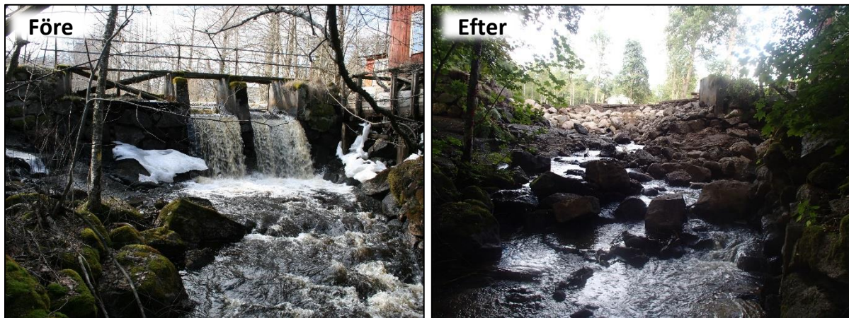
Figur 38. Gäbo såg i Knipån före och efter utrivningen 2013 (Foto: Jönköpings Fiskeribiologi AB).
