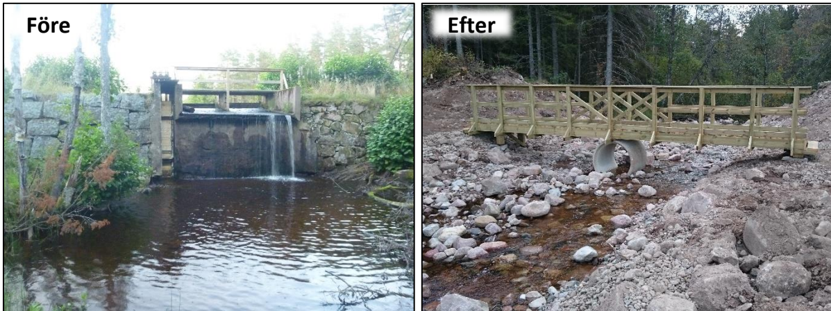
Figur 45. Lövsjöns utlopp i Lövsjöbäcken före och efter utrivningen 2015 (Foto: Jönköpings Fiskeribiologi AB).
