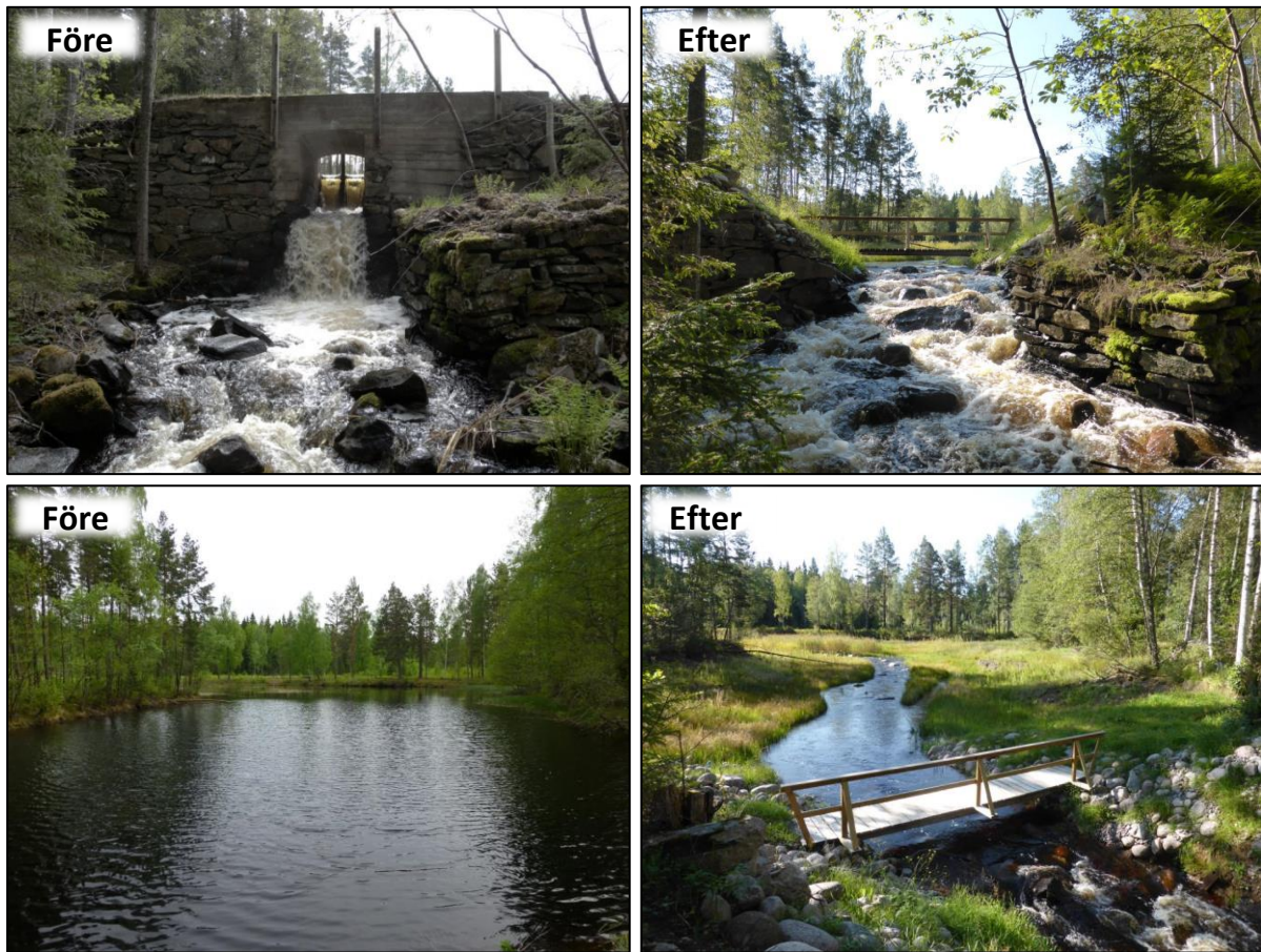
Figur 32. Kvarndammen i Fräsebäcken före och efter utrivningen 2013 (Foto: Länsstyrelsen i Örebro län).
