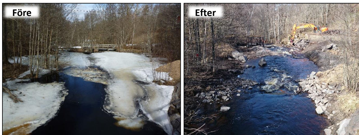
Figur 34. Huru damm i Lillån/Svartån före och efter utrivningen 2015 (Foto: Jönköpings Fiskeribiologi AB).
