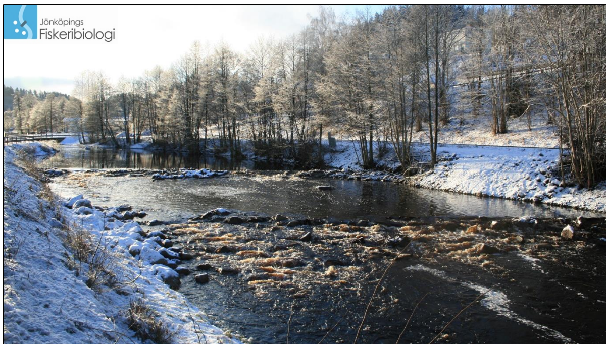
Figur 7. Massadammen i Tabergsåån där man istället för att genomföra en fullständig utrivning bibehåll en mindre del av den tidigare indämningen och samtidigt återskapade strömsträckor och passagemöjligheter för fisk (Foto: Jönköpings Fiskeribiologi AB).
