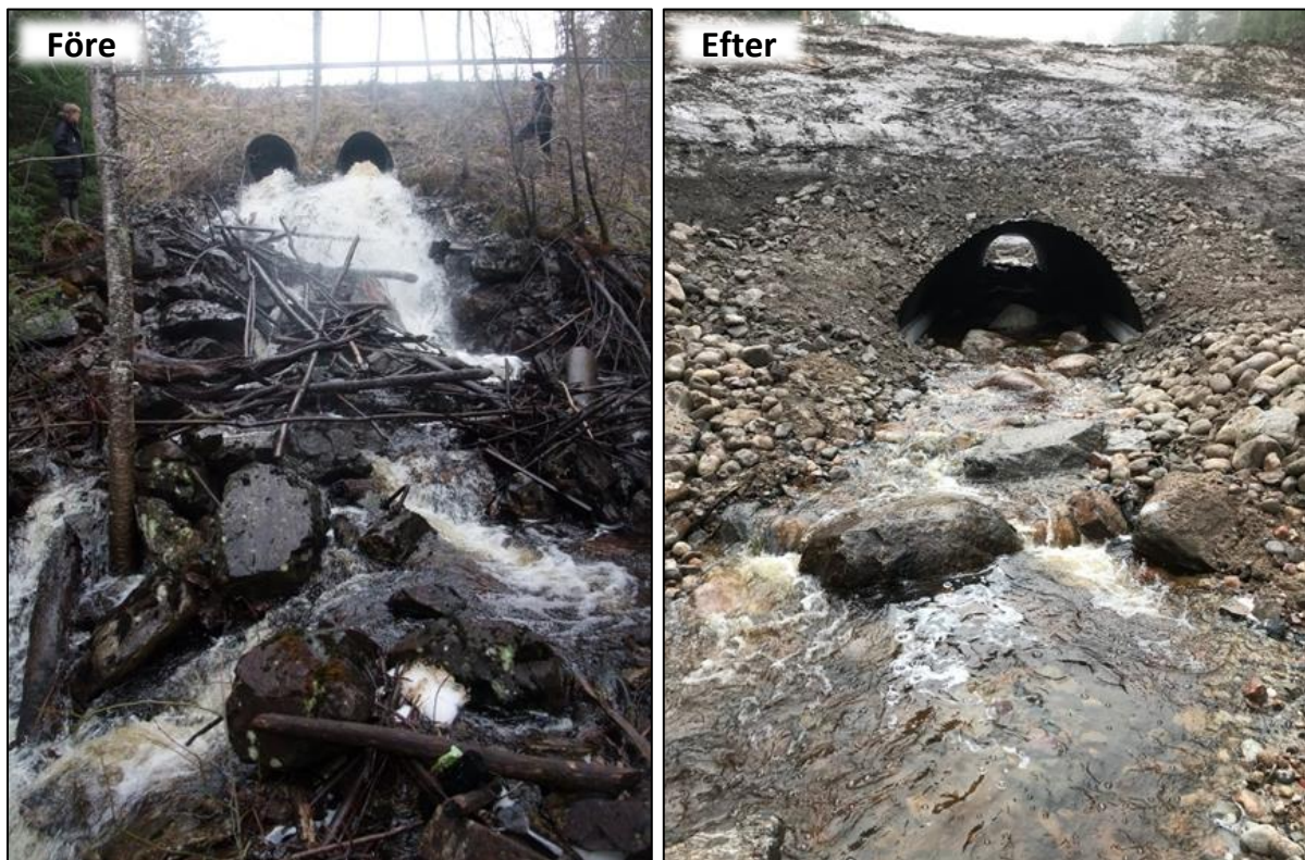
Figur 23. Väggenomgången vid Digerbergsdammen i Lerkesån före och efter utrivningen 2019 (Foto: Länsstyrelsen i Örebro län).
