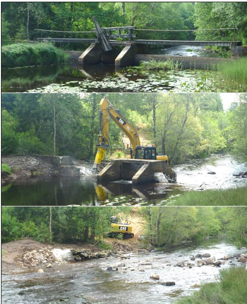
Figur 51. Bildsekvens från genomförandet av utrivningen av dammen vid Timmershult i Västerån 2012 (Foto: Jönköpings Fiskeribiologi AB).
