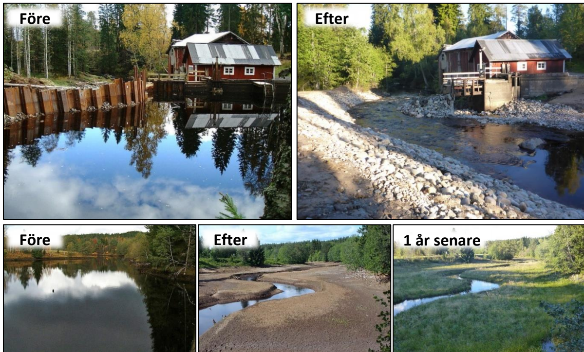
Figur 16. Danshyttans kraftverksdam i Hammarskogsån före och efter utrivningen 2015 (Foto: Länsstyrelsen i Örebro län).
